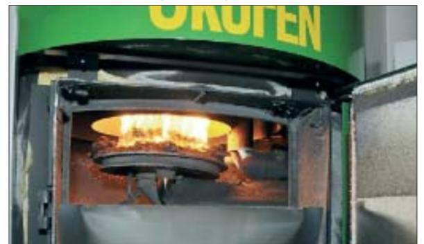
Einer der Tandem-Pellets-Kessel (Brenner) in Aktion. Die Anlage hat eine Leistung von 96 kW.
