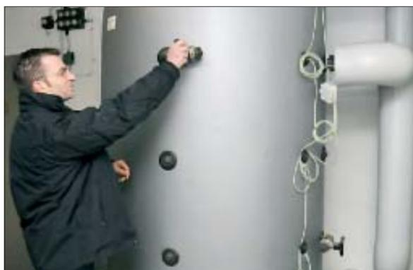
Warmwasserspeicher zur Pufferung der Energie.
